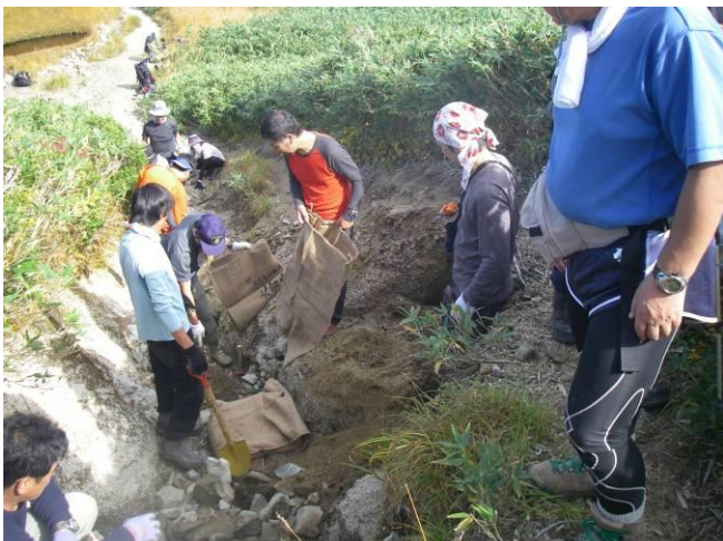
土嚢袋による土留工の設置（梶川尾根・フキアゲ沢源頭）
