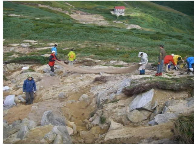
緑化ネットを敷設
