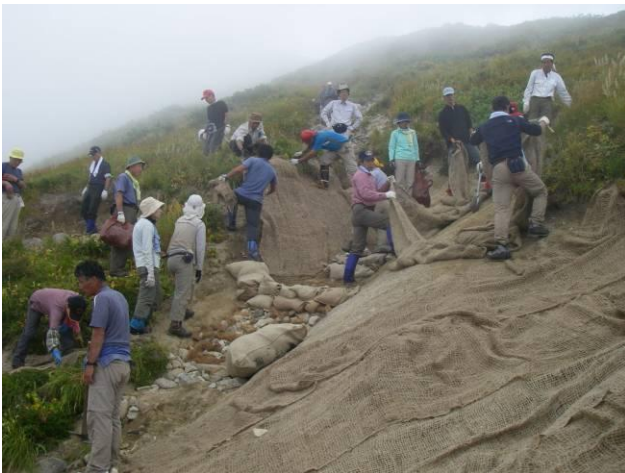
緑化ネットを敷設
