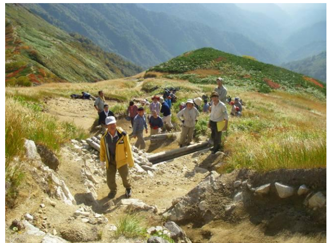
作業前に参加者で施工方法を検討します
