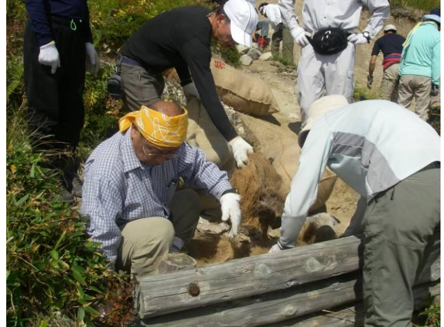
歩行路誘導の柵を設置
