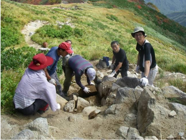
現地の転石を用いて歩行路にステップを設置
