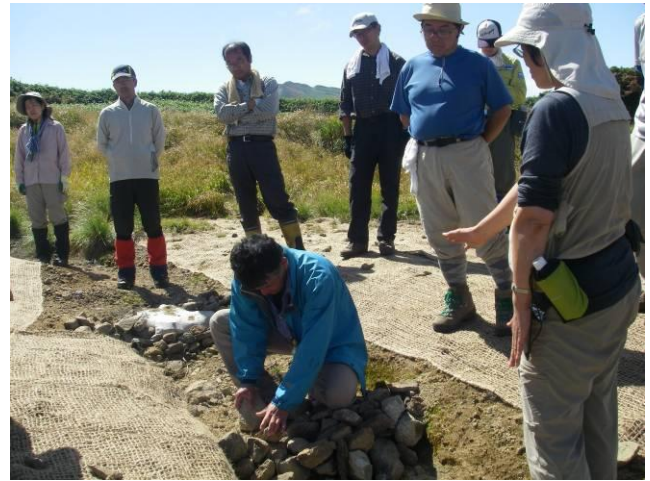
土留め工を設置します
