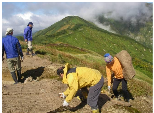
緑化ネットを敷設します
