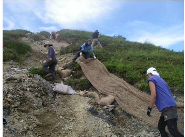
緑化ネットを敷設
