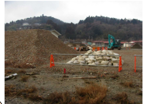
震災がれき撤去後（25.2.15撮影） 再生資材置場として使用中
