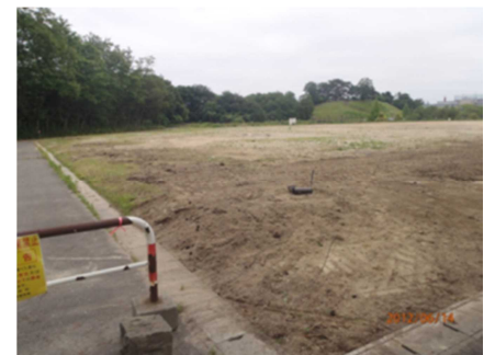
撤去後（24.6.14撮影） 野球場側半分を駐車場として使用中。 北側保育園がまもなく完成予定。
