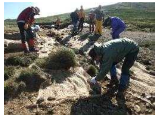
◆ 登山道の保全作業（植生ネットの敷設）
