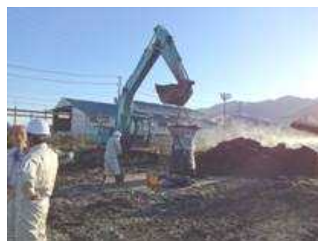
選別物（焼却処理対象）袋詰め作業 （悪臭防止のため2重フレコンバッグこん包後、 処理先へ移送）
