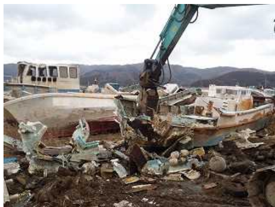
重機による被災船舶の処理 写真提供：宮城県農林水産部
