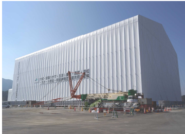
解体中（民家が近いので全覆密閉養生方式を採用）
