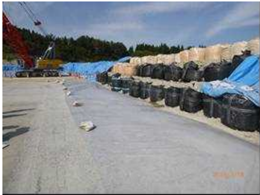
フレコンバッグ詰め埋立 土壌層敷設後埋立
