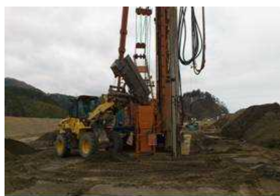
サンドコンパクション工法による再生砂の北上川堤防復旧工事への利用 宮城県石巻市
