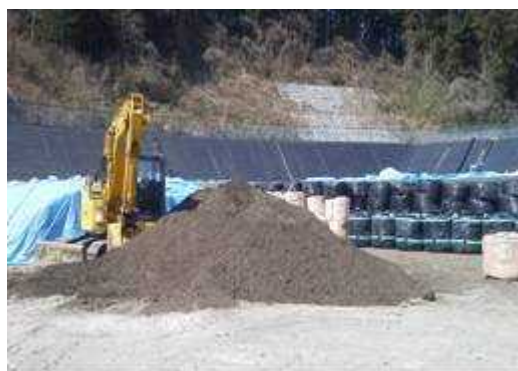
津波再生土を中込土、覆土材として利用
