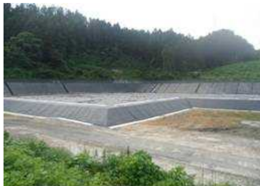
最終処分終了、覆土に津波再生土、購入土を使用し、遮水シートで被覆
