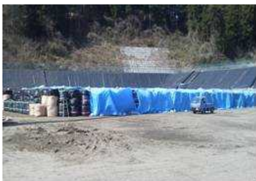
仙南最終処分場へ亘理名取ブロックの焼却飛灰をフレコンバッグ詰めで搬入
