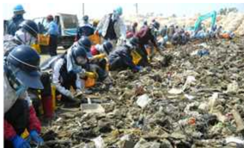
宮城県東松島市の仮置場におけるローラー方式手選別
