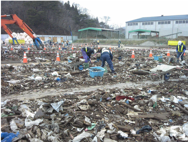
① 一次選別：災害廃棄物を展開し手選別及び重機による危険物類・貴重品等を一次選別 (岩手県宮古地区)
