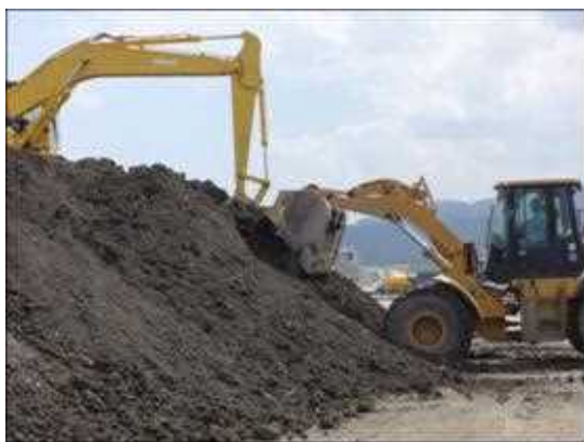
乾式分級後 30mm アンダーを湿式工程へ
