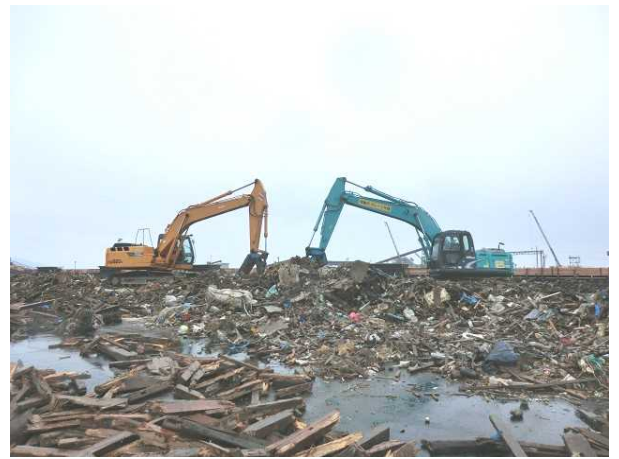
② 一次破碎：重機による粗破碎・選別 (宮城県石巻ブロック)
