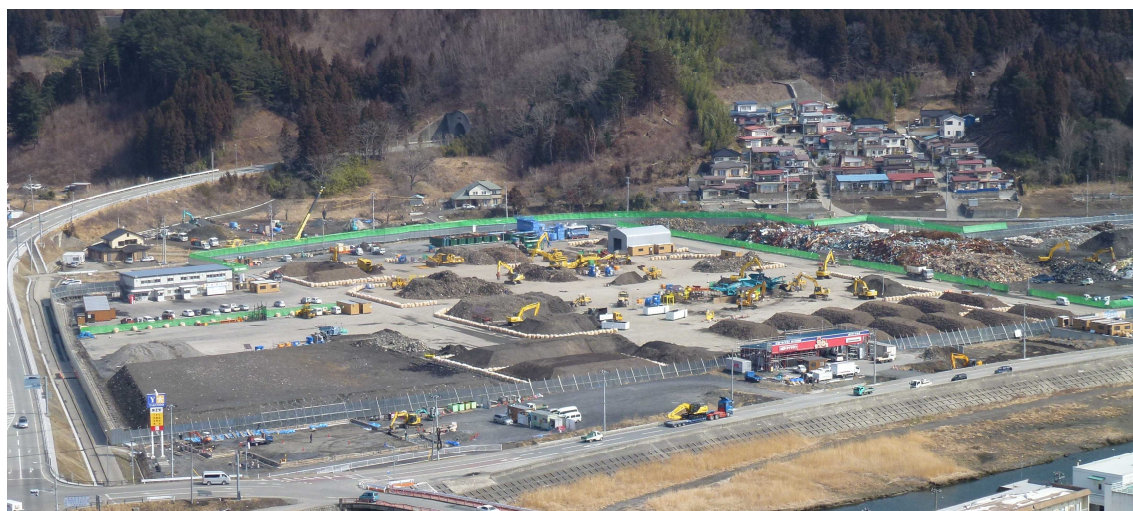
図 3.2.8 二次仮置場施設（小規模の例）（岩手県大槌地区：敷地面積 4.0ha）
