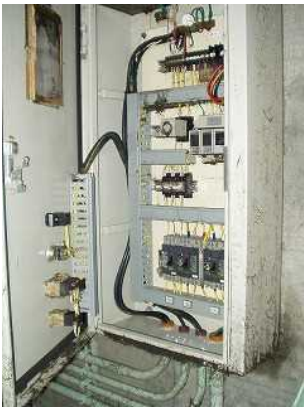
1階に設置され浸水した計器類やサーバー等（石巻広域クリーンセンター） 宮城県石巻市 写真提供：（一財）日本環境衛生センター
