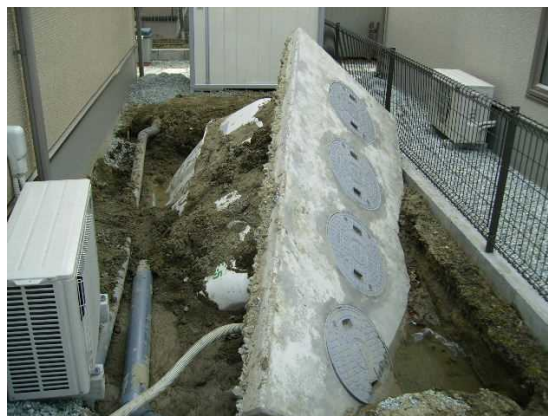
液状化による浄化槽の被害 写真提供：(公社)宮城県生活環境事業協会
