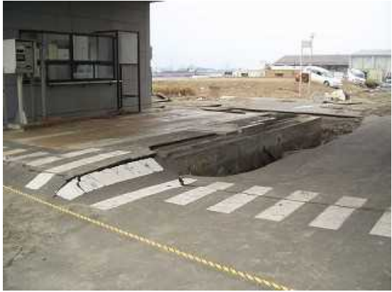
トラックスケール周辺の沈下（石巻広域クリーンセンター） 宮城県石巻市 写真提供：（一財）日本環境衛生センター
