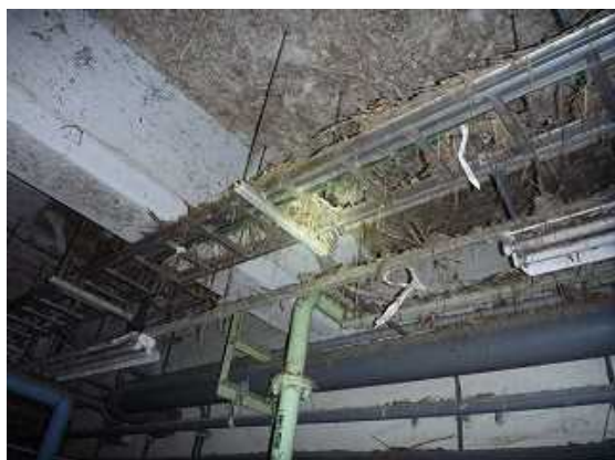
天井まで土砂が流入した、し尿処理施設の地下 写真提供：(一財)日本環境衛生センター
