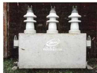
PCB 汚染物 (コンデンサ)
