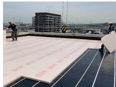
屋根の高断熱化
