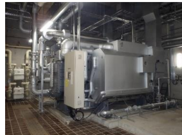
高効率ガス吸収式冷温水機
