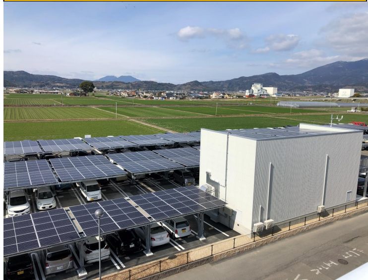
ソーラーカーポート及び太陽光パネルの設置
