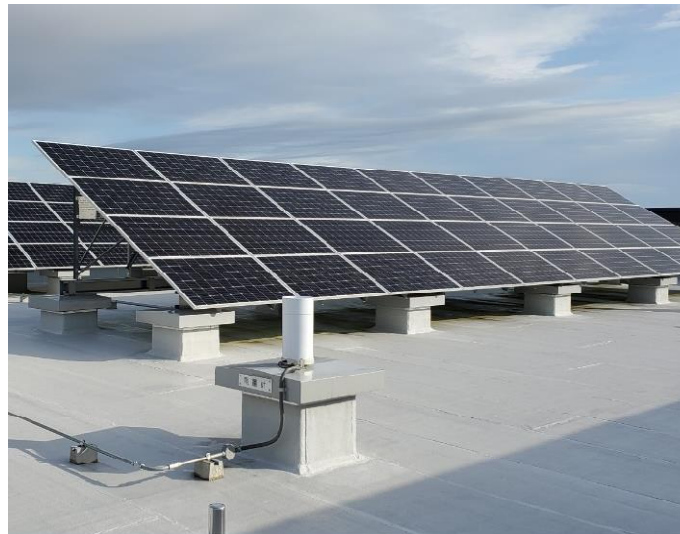
太陽光パネルの設置
