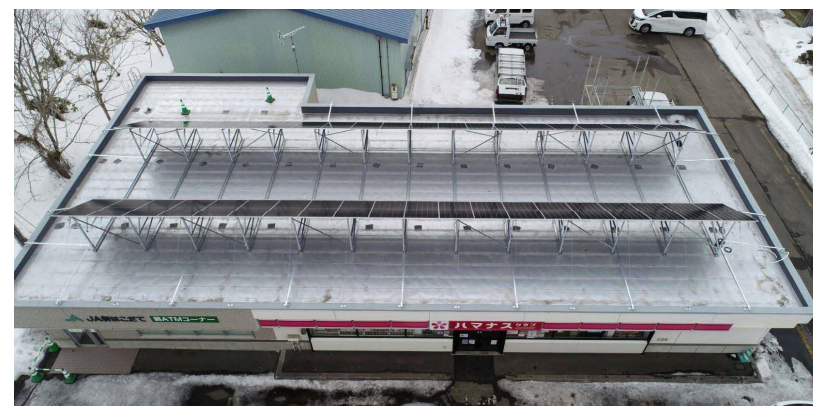
屋根を銀色塗装し、両面からの発電が可能なパネルを採用(出力: 23.6kW)
