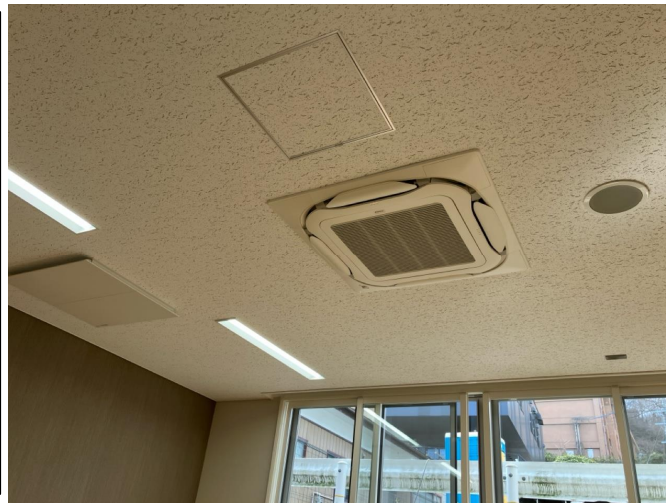
改修後の室内
