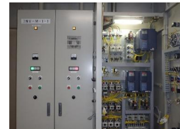
給排気ファンのインバータ制御
