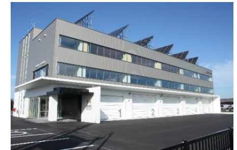
導入施設: 白糠消防庁舎
