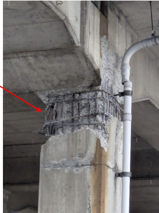
JR八戸線高架橋の損傷状況
