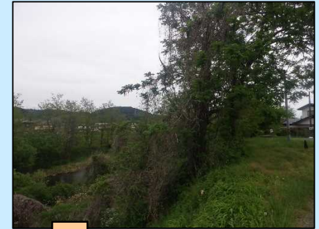
【伐採状況写真】(県)
