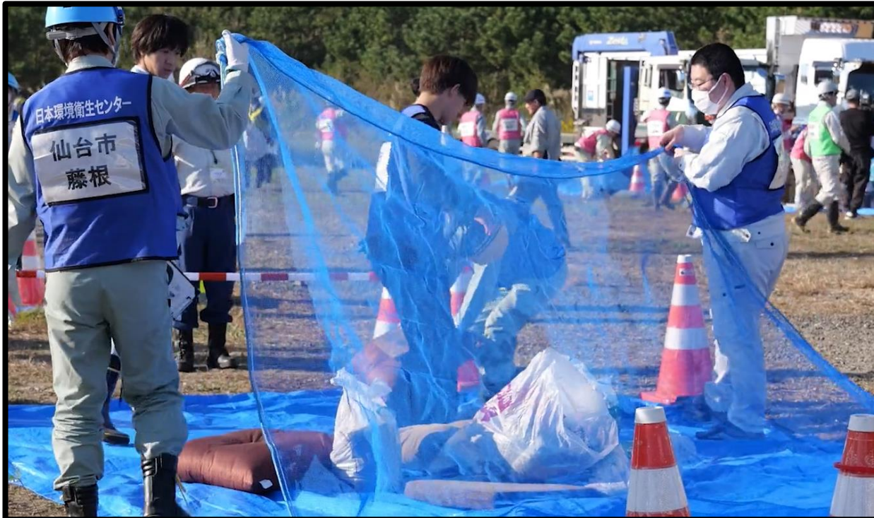
図19 飛散防止ネットの設置
