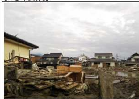
【A地区被災現場】
