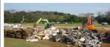
仮置場での分別の状況 仮置場配置図 写真 No.5 20▲▲年◆月◆日撮影
