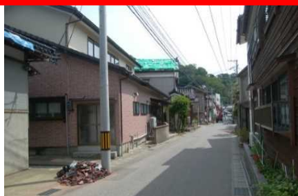
屋根瓦 の落下
