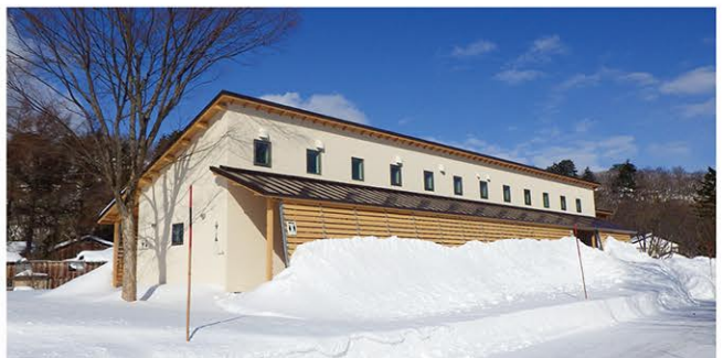
十和田八幡平国立公園（休屋北駐車場トイレ）
