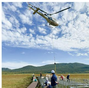
磐梯朝日国立公園（雄国沼木道工事）
