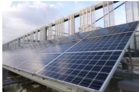
太陽光発電システム(10kW)
