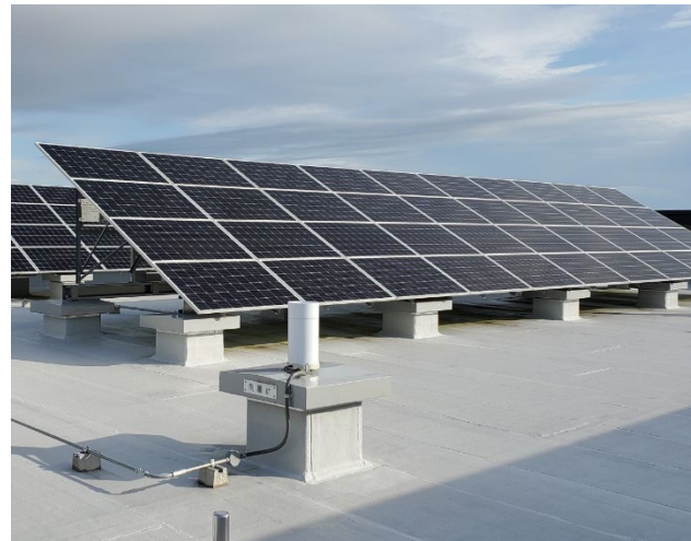
太陽光パネルの設置
