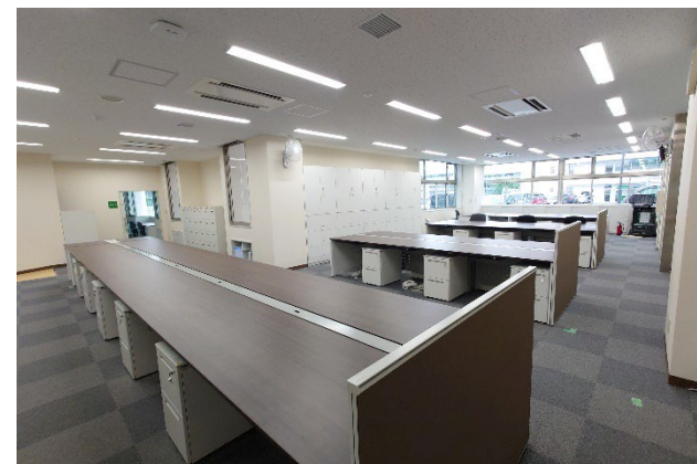
LED照明の導入
