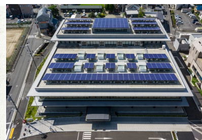
太陽光発電 (159kWh)
