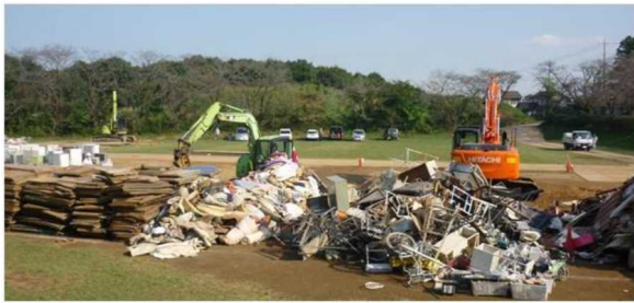
仮置場での分別の状況 仮置場配置図 写真 No.5 20▲▲年◆月◆日撮影
