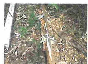
仮設支柱の倒壊(B-5)
