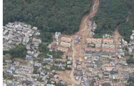
③土砂災害の状況 (広島県広島市)
