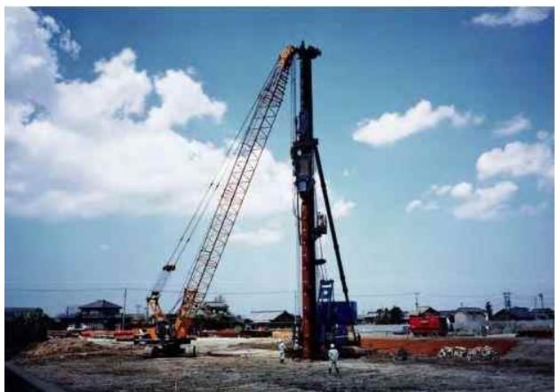
写真: 工事現場の様子 (出典: 「土木工事施工管理基準の手引き」(農林水産省))
