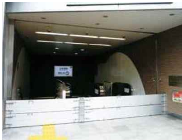
写真: 防水板の例(出典: 国土 交通省 地下街等における浸 水防止用設備整備のガイドラ イン)
