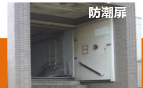
地下鉄出入口の浸水対策
