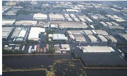
タイ ロジャナ工業団地の浸水状況 (2011年10月～11月) 出典：国土交通省 水防の基礎知識
