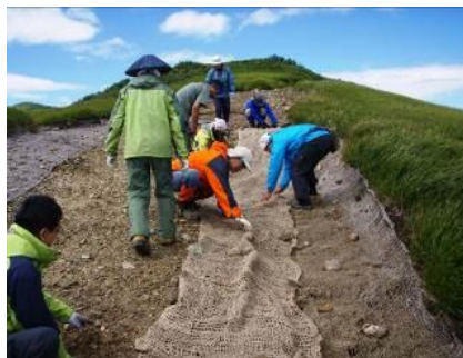
【A1 班：緑化ネット敷設】
