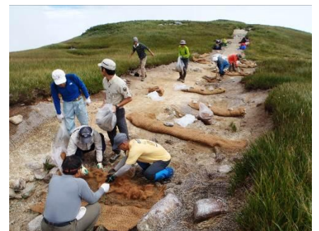
【A2 班：土留追加設置】
