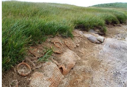
【A3 班: ヤシ製ポットによる壁面保護法】
