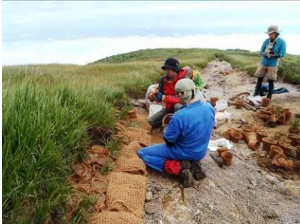
【A3 班: ヤシ製ポットによる壁面保護法】
