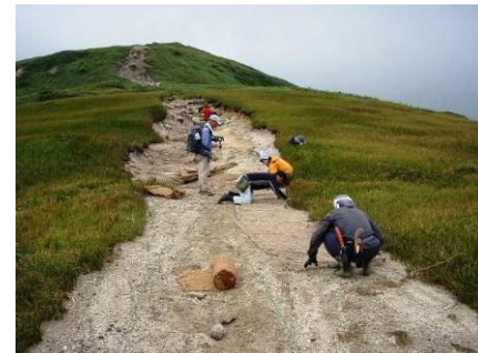
【C工区の③植生ネット敷設】
