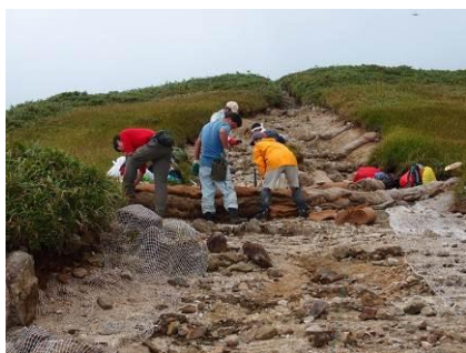
【C工区の①排水工】
