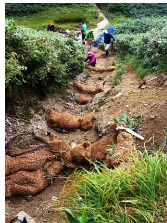
【B工区の土留め工→】
