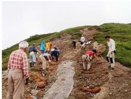
【C工区の②土留め工】
