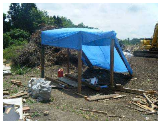
作業現場付近に設けられた休息所 (柱はガレキの一部を有効利用)
