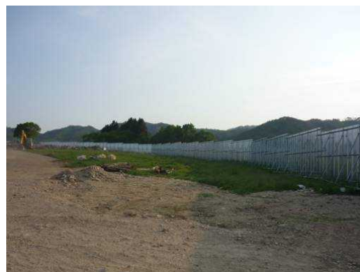
仮置場周囲に設置されたフェンス (岩手県田野畑村)
