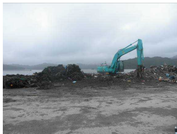
重機による漁具の裁断・選別
