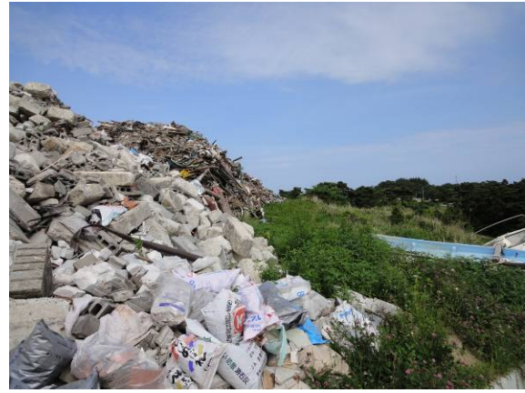
仮置場（積み上げが高く、のり面の角度が急）
