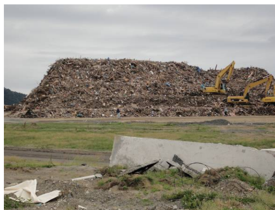
仮置場（野蒜地区）（木くず、積み上げが 高く、のり面の角度が急）
