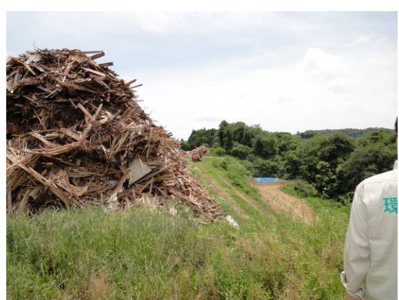
仮置場（森林組合）（木くず、積み上げ が高く、のり面の角度が急）
