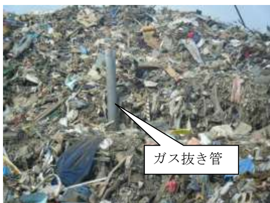
混合物の山に設置されたガス抜き管
