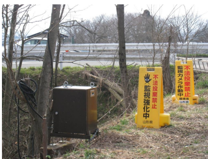
監視カメラと警告看板
