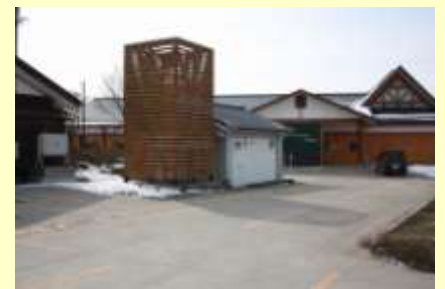
ペレットボイラーでロードヒーティングも行っています
