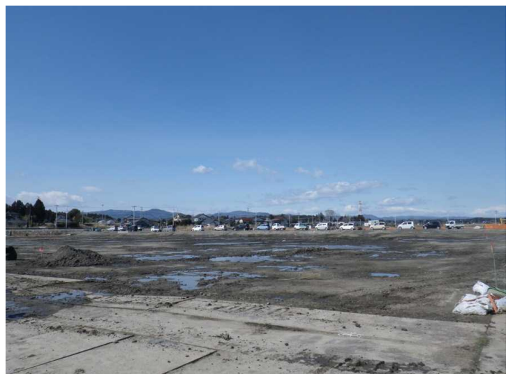
がれき撤去後
