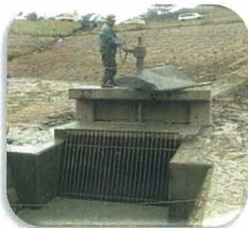
底樋を開けて完全に排水
