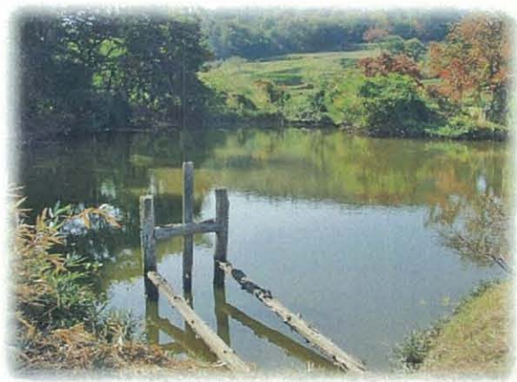
古いため池の取水施設
