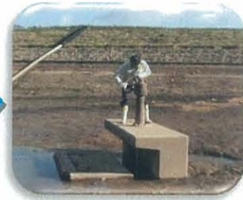
底樋から排水
