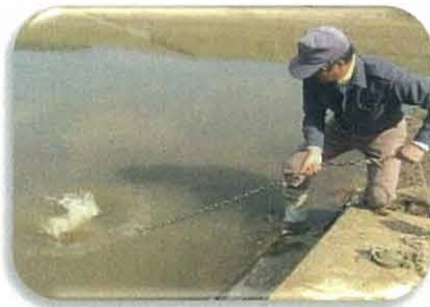
斜樋の取水口を開栓し
