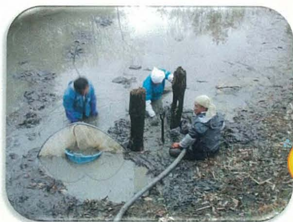
泥に埋もれた底樋の掘削作業
