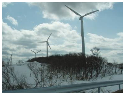
風力発電施設(袖山高原)
