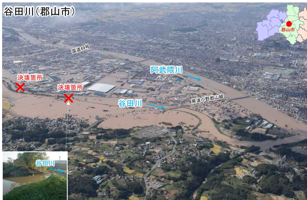
令和元年東日本台風による被災状況 出典：福島県土木部土木企画課HP
