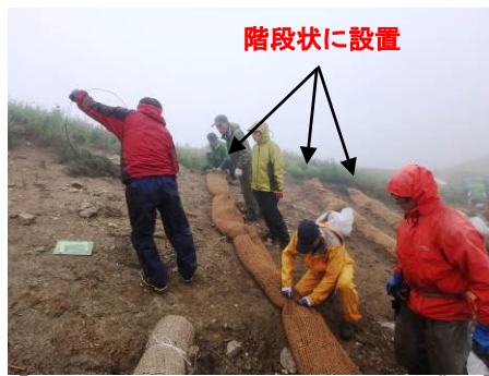
【B班 ヤシネットロールの土留（作業中）】
