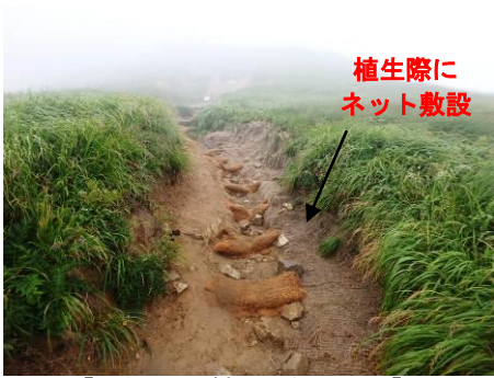
【A班 ヤシ製土のうの土留】
