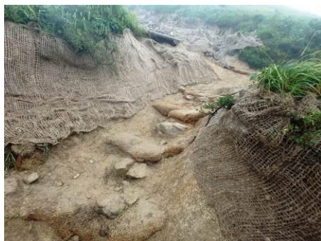
【C班 予め土砂をかけたヤシ製土のうの土留】
