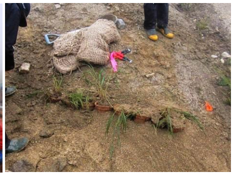
【B班 ヤシ製ポットによる緑化（作業中）】
