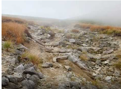
玄山道分岐 流水路と分離した歩道は問題なく機能していた
